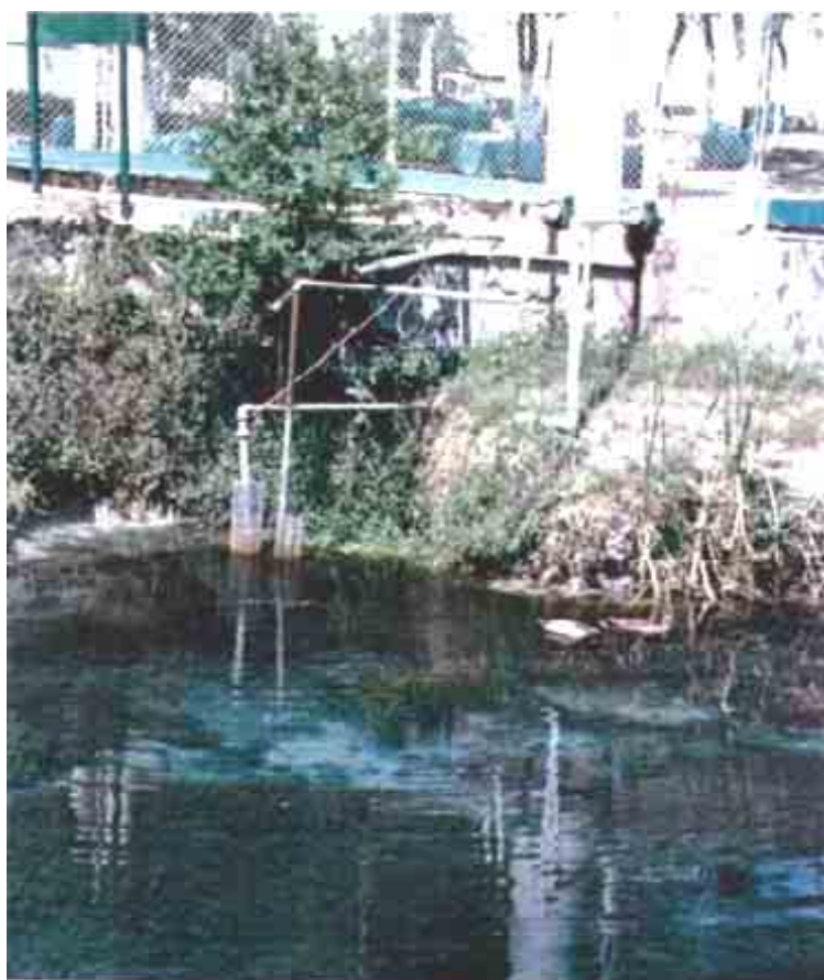
Bomba de agua en el Ojo de Agua de Apodaca. Se observa la disminución progresiva del nivel
